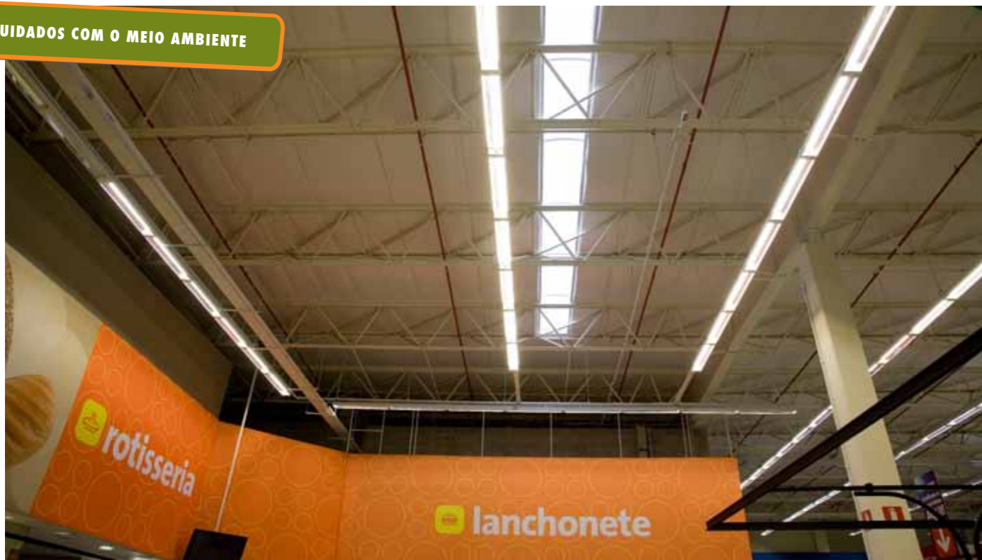
Lâmpadas T5 e claraboia para maior iluminação natural
